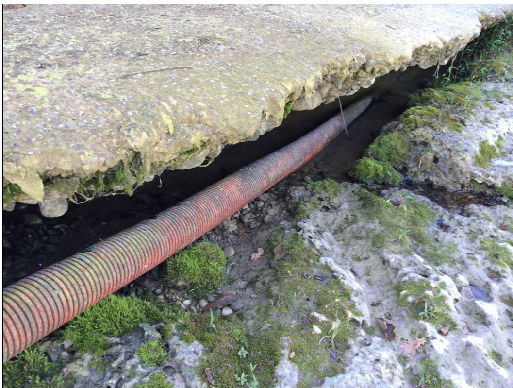
Foto 11: Linea DN 600 mm alto Montello a vista a seguito dell'erosione della corrente
