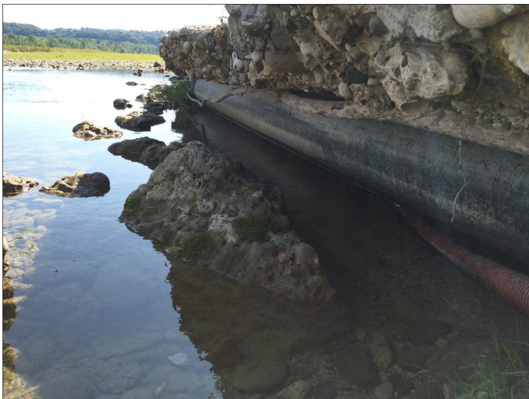
Foto 12: Linea DN 600 mm alto Montello a vista a seguito dell'erosione della corrente
