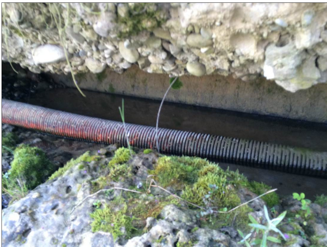
Foto 10: Linea DN 600 mm alto Montello a vista a seguito dell'erosione della corrente
